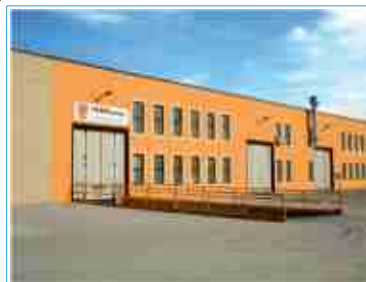
Завод по производству насосов с магнитной муфтой. 3 000 м 2 , Ровиго
