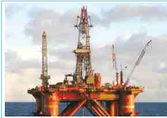
Перекачка морской воды на нефтяных платформах
